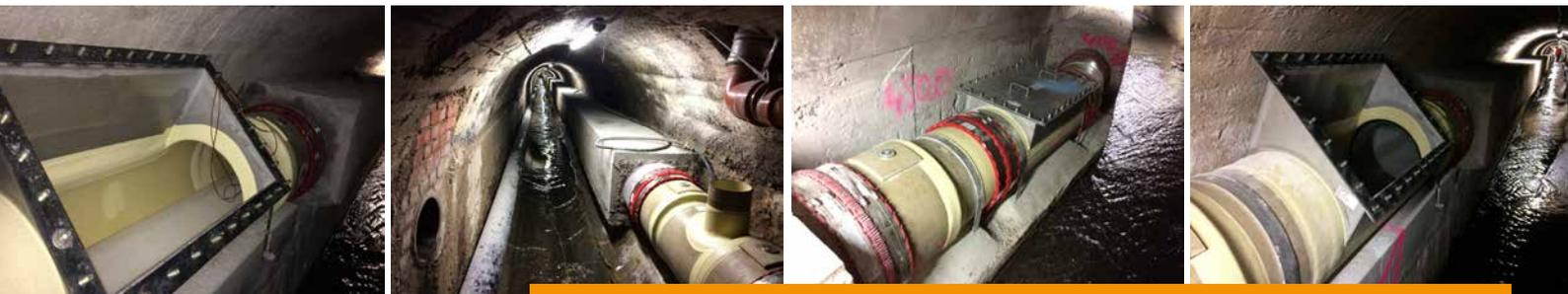
Krätzbachgewölbe Fulda (v.l.n.r.): GFK-Wartungsöffnung im Altkanalbestand DN 500 STZ; Nennweitenänderung auf DN 400; vor Linereinbau DA 477 in Stützgewebe; MW-Kanal nach Sanierung mit Schlauchliner auf 390 m Länge
